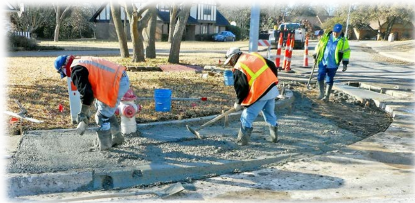
ADA ramp construction
